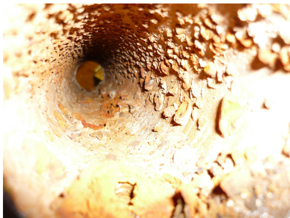
Figuur 2: verruwing van het oppervlak van leidingen. (bron: MIC-Europe BV)
